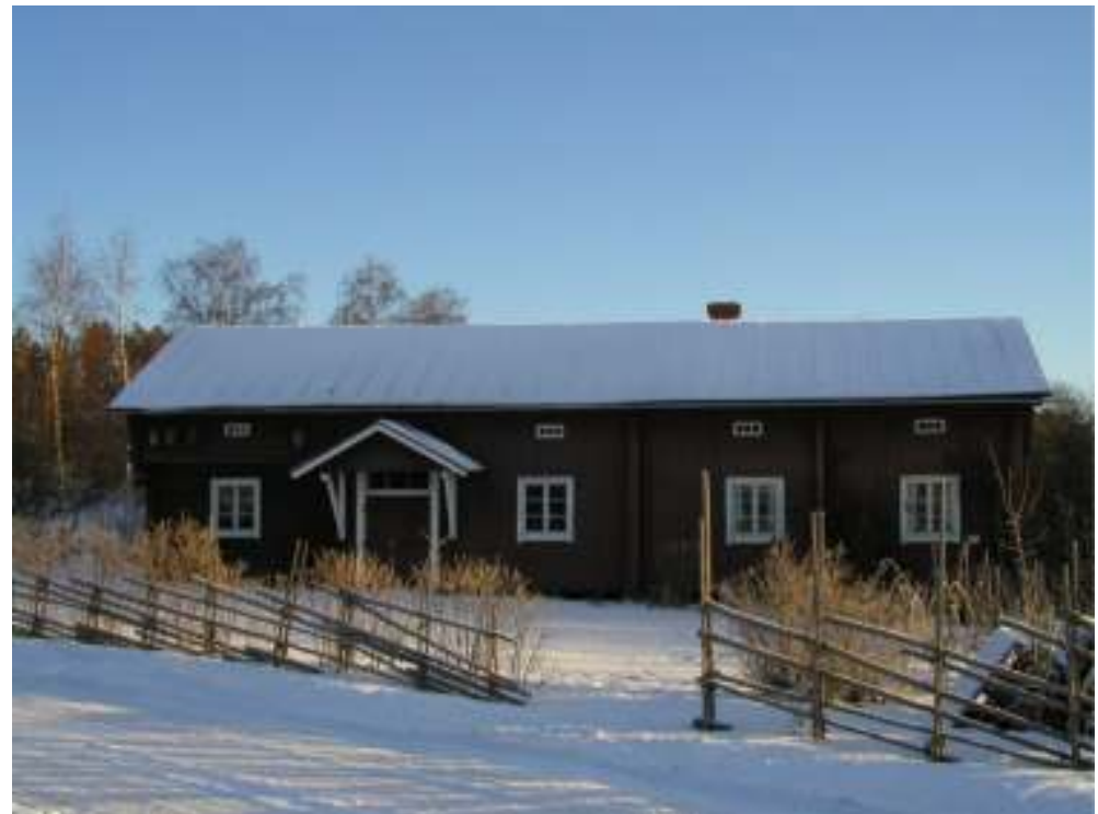
...ja Nautelankoskella vuonna 2002. Tämän rakennuksen ulkoasu ei ole muuttunut.
